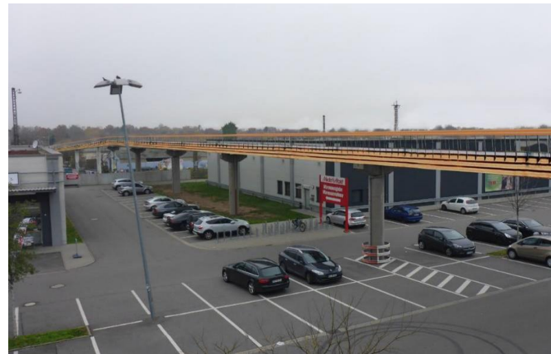
Blockträger Brettschichtholz
